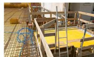
14 L'échelle dépasse d'au moins 1 m le point d'appui supérieur.
