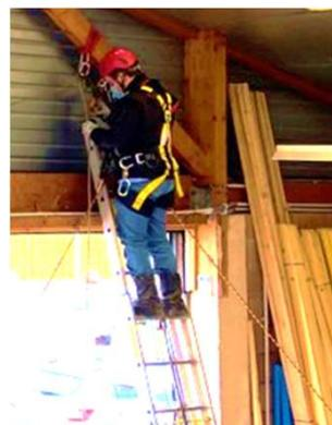
2 **À partir d'une hauteur de chute de plus de 2 m**, les travaux à partir d'échelles portables ne peuvent être que de **courte durée** et il convient de prendre des **mesures de protection contre les chutes.**
