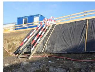
3 Dans les fouilles pour la construction de conduites de service, on peut renoncer à une protection latérale si aucun travailleur ne doit se trouver à proximité du bord de la fouille et que le chantier est signalé de manière bien visible.
