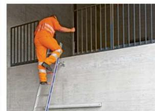
15 Dispositif de retenue, garde-corps près de la zone à risque de chute et sommet de l'échelle sécurisée
